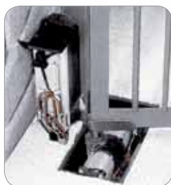
Installazione martinetto e centralina - vista interna
